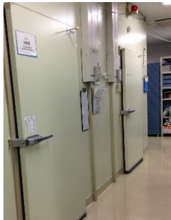
↑プレハブ冷蔵庫 外観 (左) と庫内 (右) 奥の扉から入り、2室の間の中扉を介して手前の治験薬専用庫に入室
